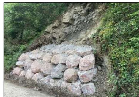
Réparation glissement voie communale de la Romiguière, commune du Truel.
