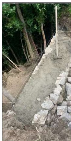
Réparation glissement , commune de Verrières.
