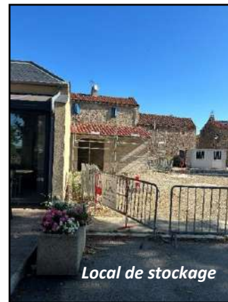
Construction du local de stockage
