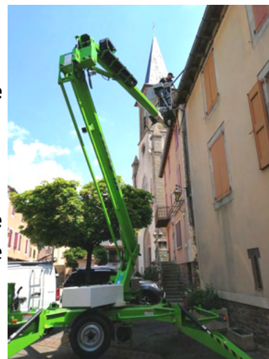
Travaux d'entretien sur la toiture du presbytère de Melvieu
