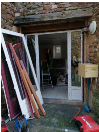
Changement en cours des menuiseries du presbytère et de l'ancienne épicerie de Melvieu
