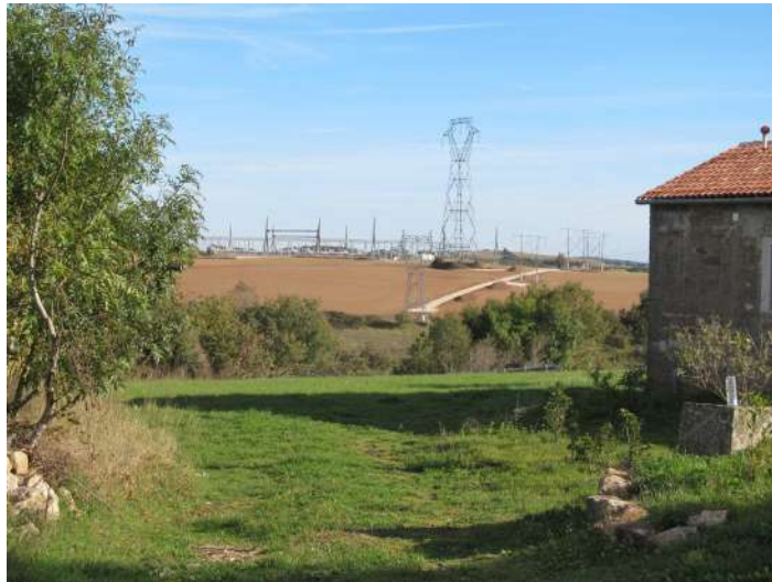
Vue sur le chantier du futur transformateur "Sud-Aveyron" depuis Ayres
